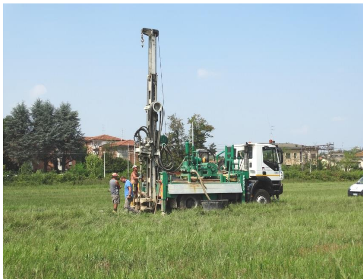
Fig. 8: Realizzazione del sondaggio S2 con vista delle aree interessate dalla realizzazione della vasca
